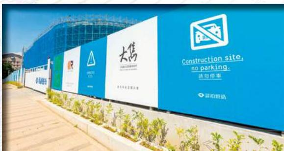
晨禎自行開發具有綠化結構鋼模的圍籬，其混凝土止水防液墩座可重覆再使用達15次以上。
